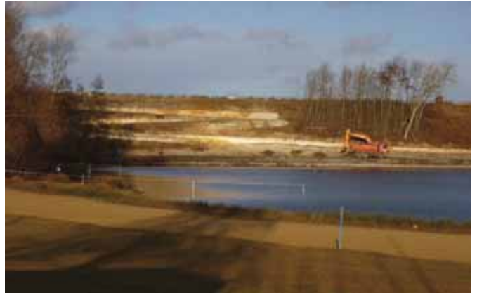
Umfangreiche Baumaßnahmen wie hier am Rampenweg zwischen Seepromenade und Uferweg werden 2012 und 2013 am Südufer im Bereich der Seebühne und des neuen Seebades stattfinden.
